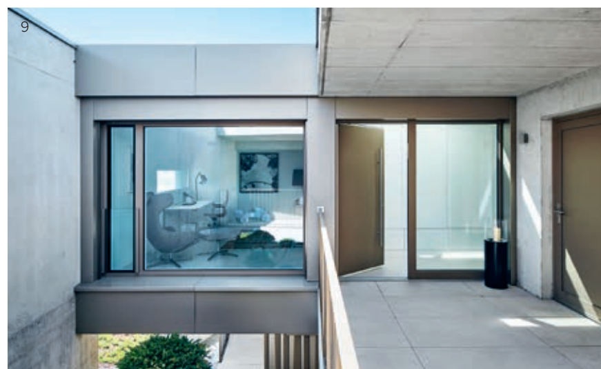
7| Die speziellen Fenster und Fenstertüren fügen sich optimal in die Fassade ein und halten dem Druck des Windes vom See aus stand. 8| Verdeckt liegende Beschläge und flächenbündige Fensterflügel und -rahmen erzeugen klare Linien. 9| Auch die Eingangstüre musste ins Konzept passen. Die Herausforderung war, sie in die Alarmanlage des Einfamilienhauses zu integrieren.
